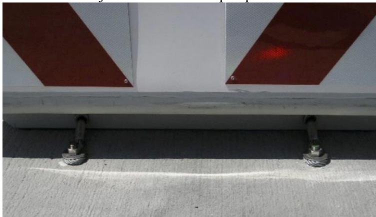
Obrázek č. 2: Zajištění fixačních lan pod přední částí tlumiče
