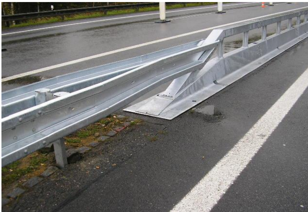
Obrázek 10 - Foto přímého napojení Varioguardu a Varioguardu MÜF na oboustranné ocelové svodidlo NHKG
