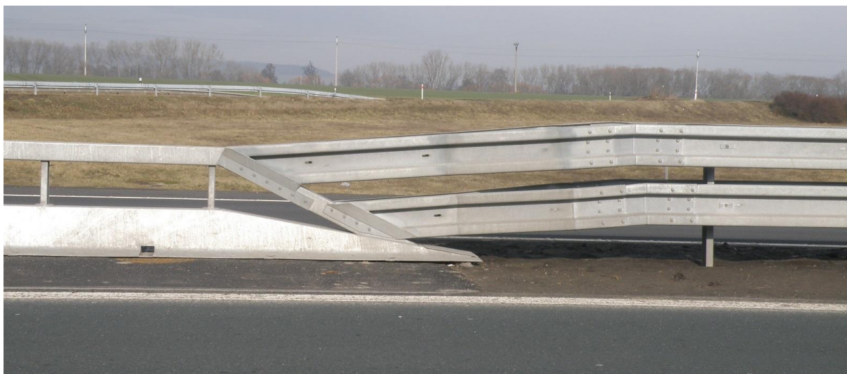
Obrázek 11 - Foto přímého napojení Varioguardu a Varioguard MÜF na oboustranné ocelové svodidlo OSNH4/H3
