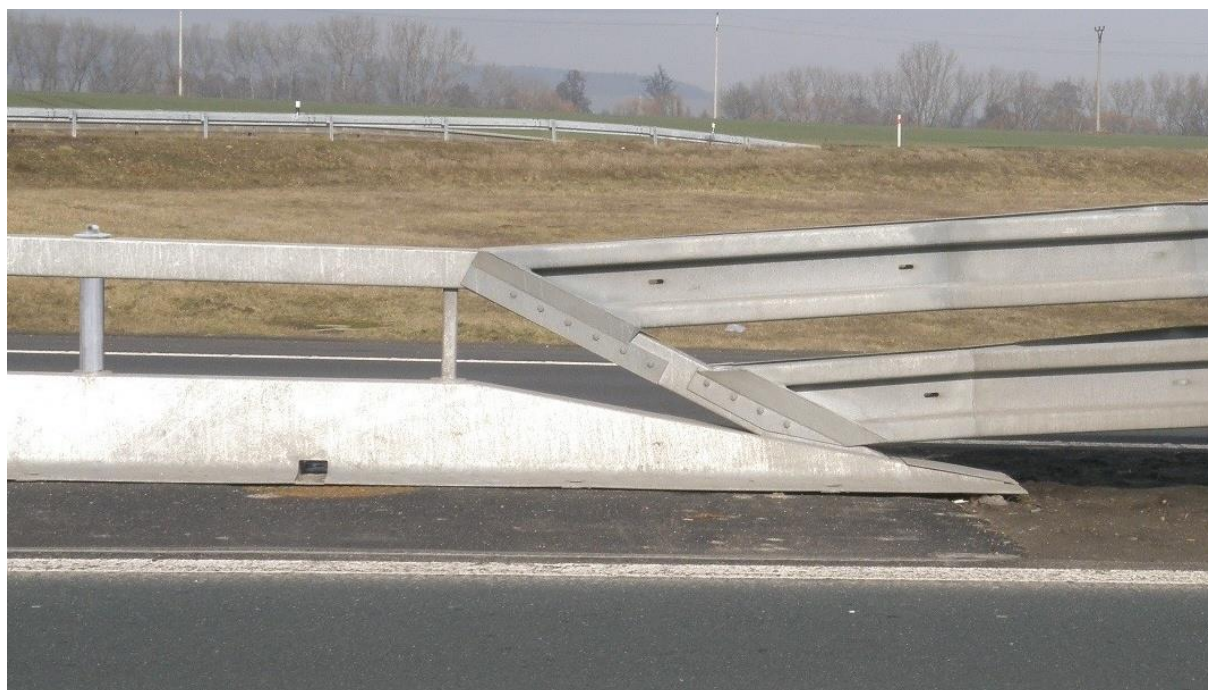
Obrázek 14 - Foto přímého napojení Varioguard MŮF na oboustranné ocelové svodidlo OSNH4/H3
