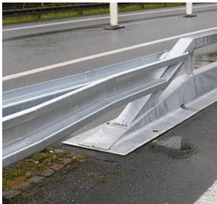
Obrázek 13 - Foto přímého napojení Varioguardu MŮF na oboustranné ocelové svodidlo NHKG
