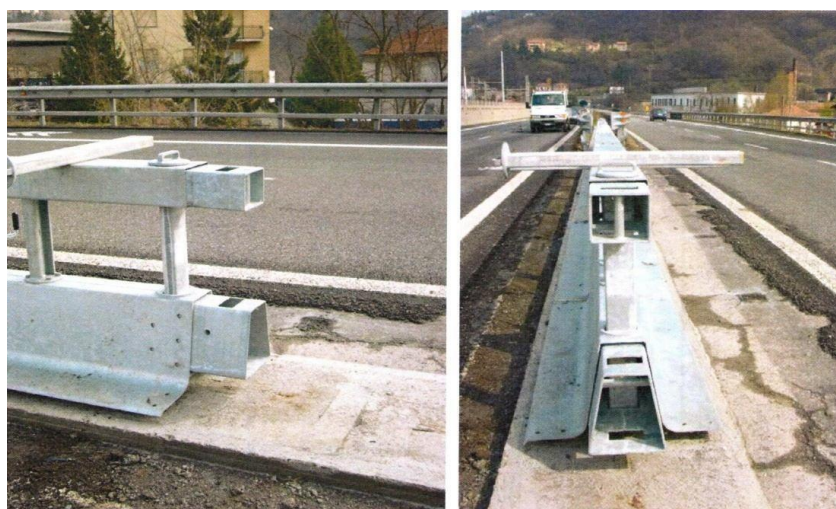
Foto 3 – detail spoje pro rychlé otevření
