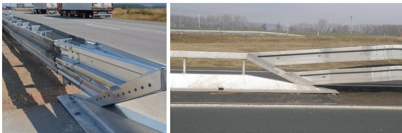
Foto 4 – možnosti napojení na ocelová svodidla Arcelor Mittal
